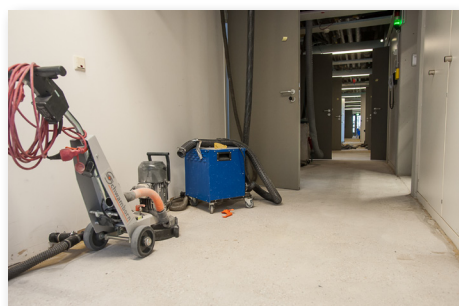
Der Bodenbelag ist schon raus.
