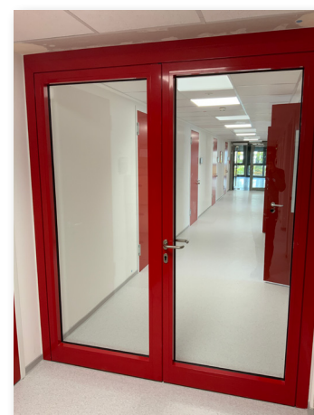
Blick in den renovierten Gang.
