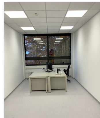
Ein saniertes Büro.
