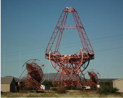
Vierbein zur Kamerahalterung und die Elevationsantriebe montiert, und zum Schluss das Teleskop auf die sechs Radsätze des Azimutantriebs gesetzt. Der rechteckige Spiegelträger von H.E.S.S. II misst ca. (24 × 32) m, die Brennweite beträgt ca. 36 m.
